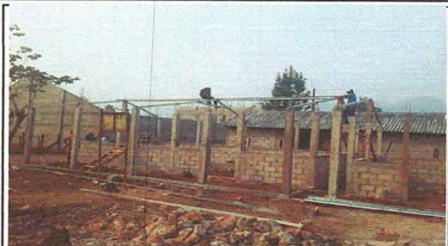
Foto 2: Instalacion de costaneras de Cocina de la EORM Comunidad Tapila
