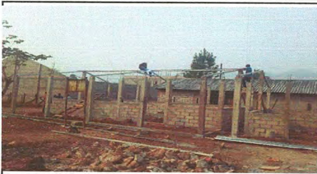
Foto1: Instalacion de costaneras que sera utilizada como salon de clase
